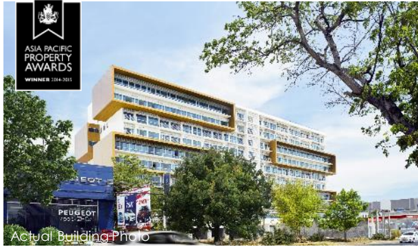
Actual Building Photo
